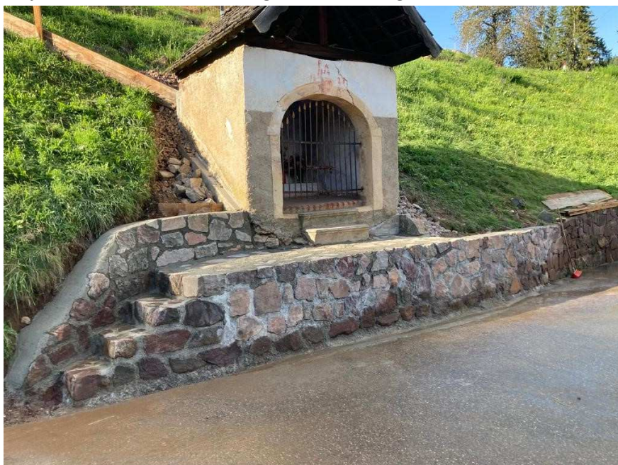
Restaurierung Kapelle Stabiet
